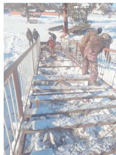
Кроме этого, подрядчик осуществляет закупку металла для осуществления укладки со стороны Кебезени для того, чтобы снизить спуск к мосту. Таким образом мост станет метров на тридцать длиннее. К тому же, будут изменены перила по высоте в большую сторону. Что касается ширины моста, то она останется такой же, как и прежде.
